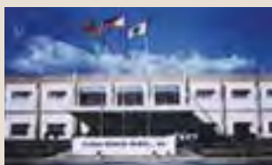
Hitachi Air Conditioning, Филиппины
